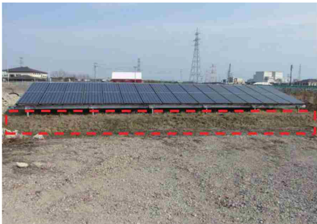
埋立物への影響を考慮し最終覆土層上部に約50cmの盛土を実施
