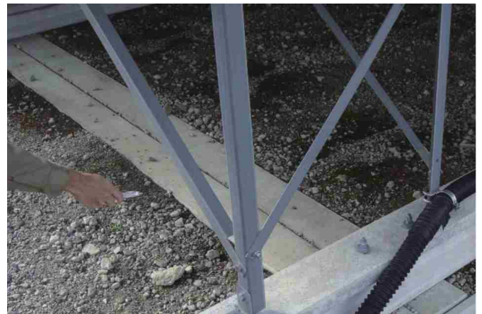
架台部には錆びにくく強度のあるZAM材(亜鉛・アルミニウム・マグネシウムの合金)を使用
