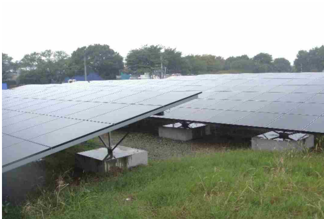
定期的な草刈りを実施(貸付面積分を事業者が、それ以外の部分を処分場管理者が担当)
