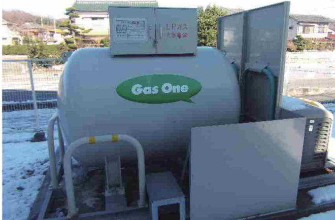
LPガスバルク発電システムと防災用具を公共施設(町役場と小中学校9か所)へ寄付
