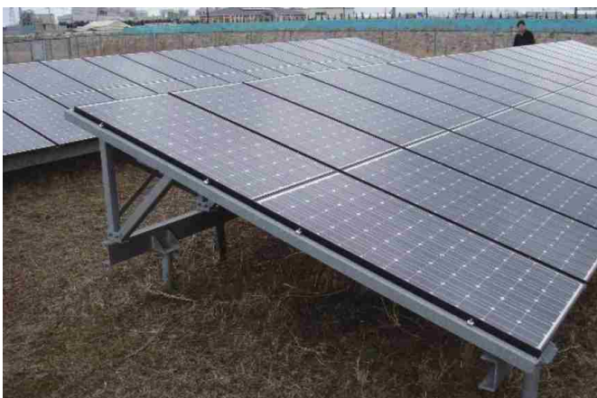
風の影響を考慮したパネルの設置
