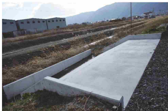
雨水は南側にある樋管から排出
