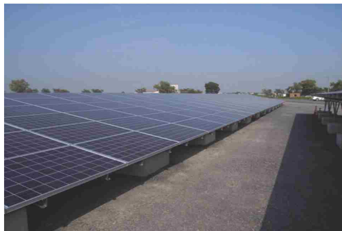
砕石を使い傾斜を設けて雨水が特定方向に流れるように工夫
