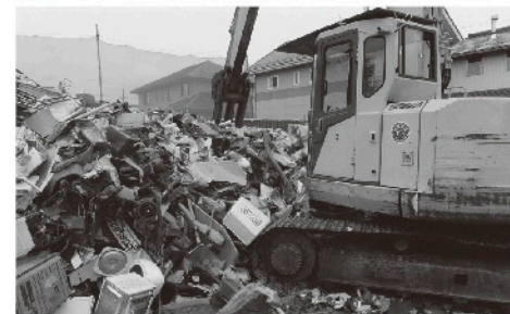
廃家電の不適正処理の現場 (国内)
