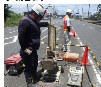
（貫入試験による調査）
