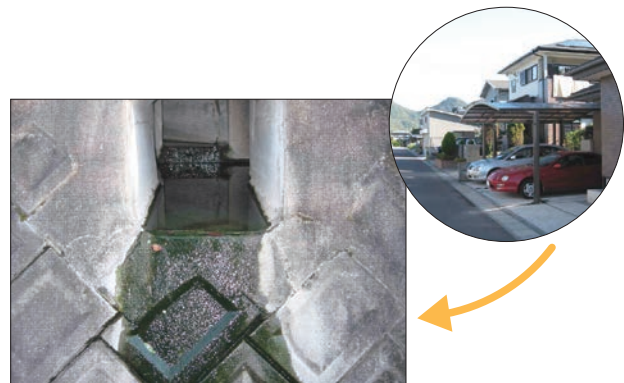
1990年代 浄化槽設置地域の側溝の例 (きれいな水が流れています)
