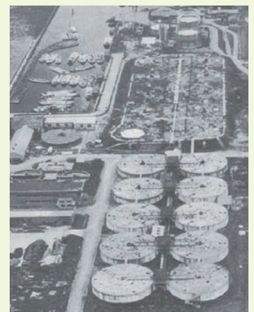
写真-1 日本最初の大規模し尿処理施設(砂町処理場, 処理能力3,600kℓ/日, 1954年) 6)
