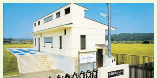
大型浄化槽（RC製）
