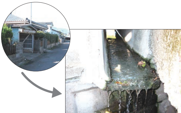
1970年代 単独処理浄化槽設置地域の側溝の例 (白っぽいへドロ状のものが堆積しています)
