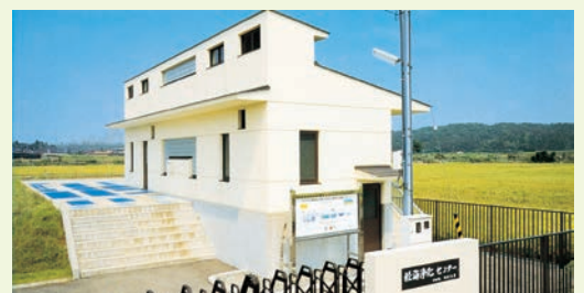
大型浄化槽（RC製）
