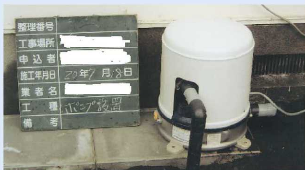
6. 水中ポンプ設置
