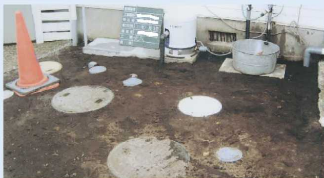
7. 雨水貯留槽 完成
