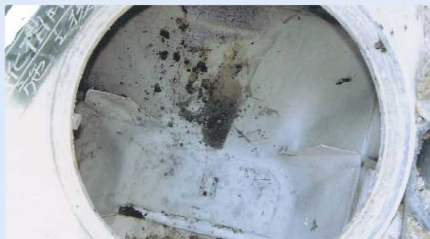
2. 浄化槽解体施工
