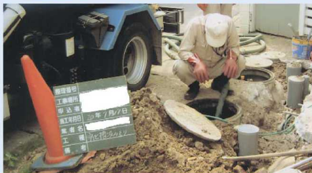
1. 浄化槽汲取り
