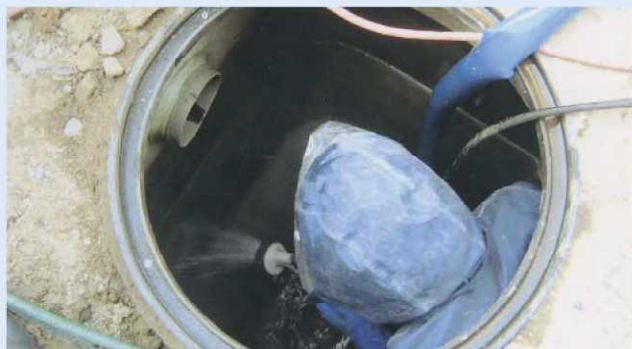
3. 浄化槽内清掃
