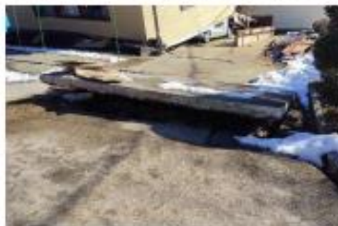
地震により浮き上がった浄化槽（画像は珠洲市内の例）
