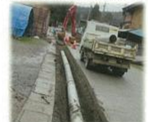
仮設の水道配管工事（送水管の延長）
