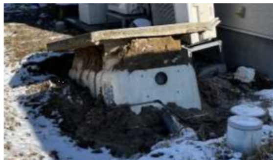
地震により浮き上がった浄化槽（画像は七尾市内の例）
