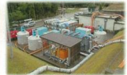
仮設の設備工事 (珠州市・宝立浄水場の機能回復)
