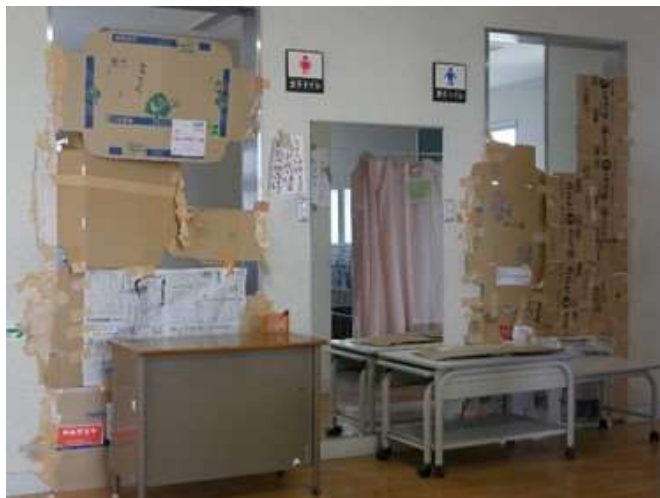
入口を閉鎖した避難所トイレ 2016年 熊本地震
