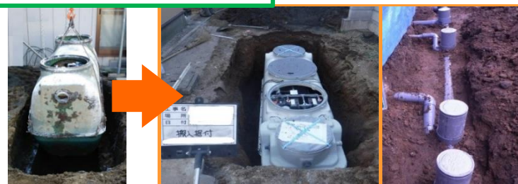
単独浄化槽撤去
