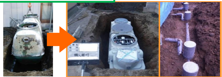
単独浄化槽撤去 合併浄化槽設置 配管工事
