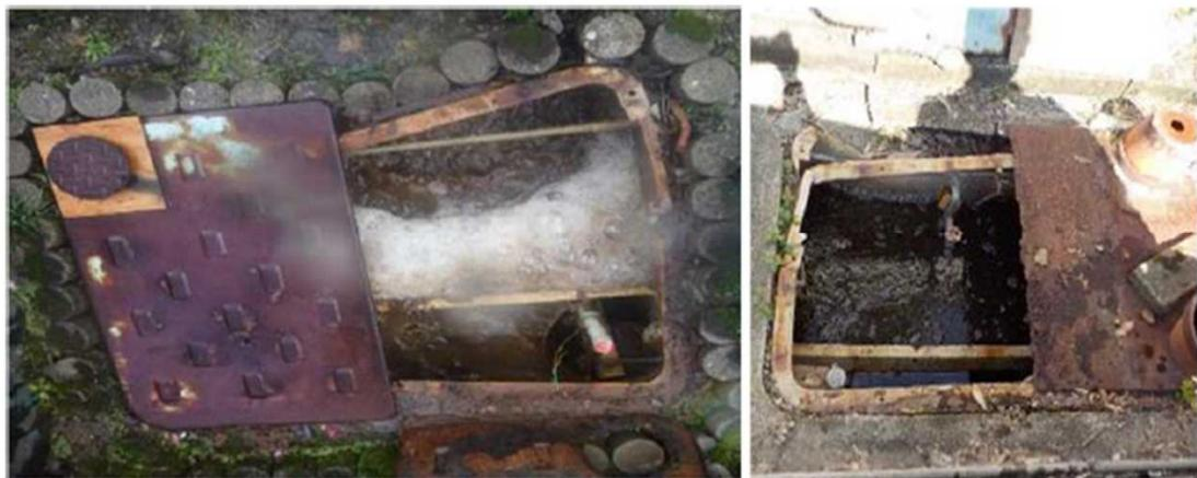
■上部から水面下まで亀裂（漏水を伴う）
