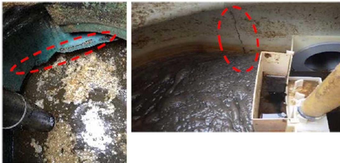
■水面より上の槽壁が破損
