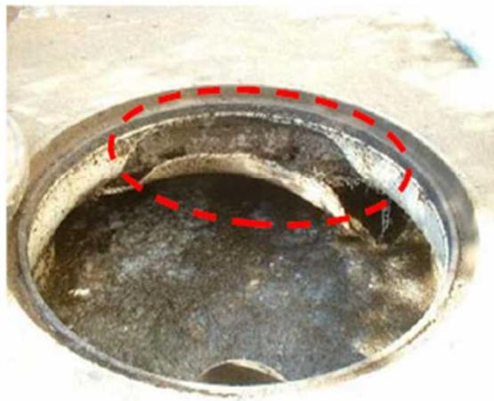
■放流管接合部の破損
