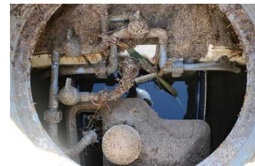
浄化槽内に土砂が流入した例
