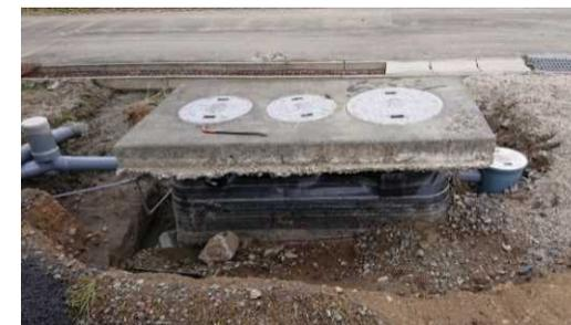
洪水により浄化槽が露出した例
