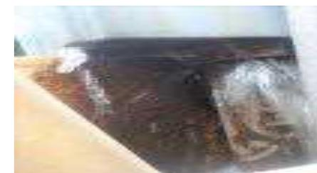
浄化槽の劣化(鋼管製バルブの腐食)
