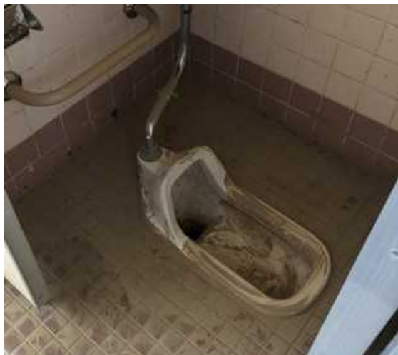
流せなくなった水洗トイレ 2018年 西日本豪雨
