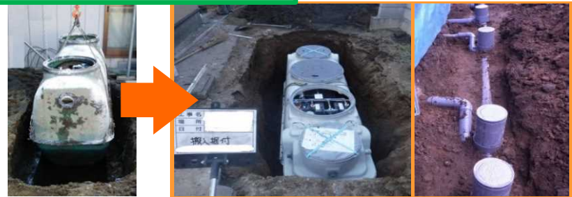
単独浄化槽撤去
