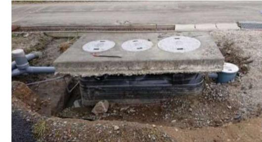
洪水により浄化槽が露出した例
