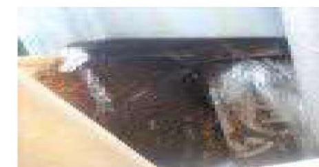
浄化槽の劣化(钢管製バルブの腐食)
