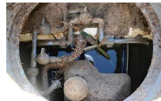
浄化槽内に土砂が流入した例
