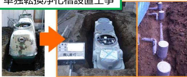
単独浄化槽撤去 合併浄化槽設置 配管工事
