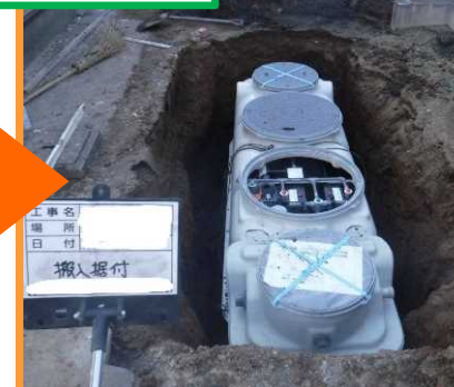
合併浄化槽設置
