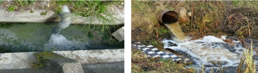
生活排水が未処理のまま水路に流入している事例
