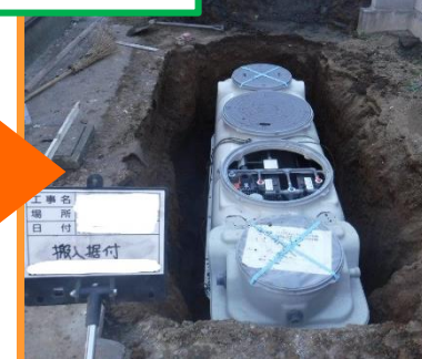
合併浄化槽設置
