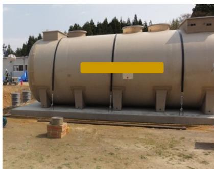
浄化槽据え付け・転倒防止措置
