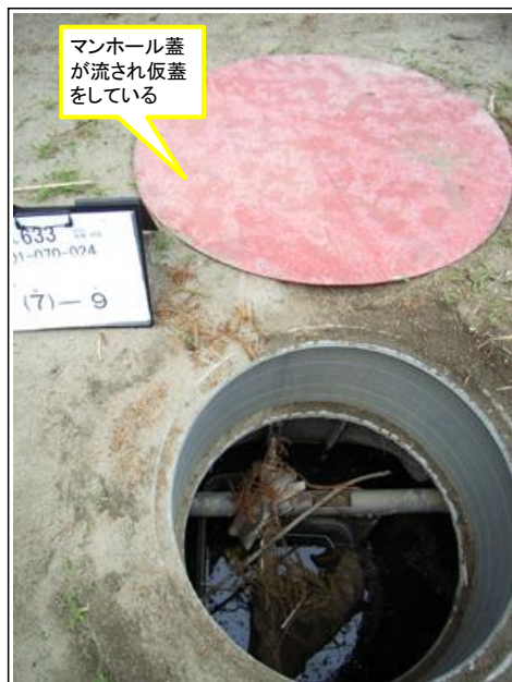
仮蓋を設置した例
