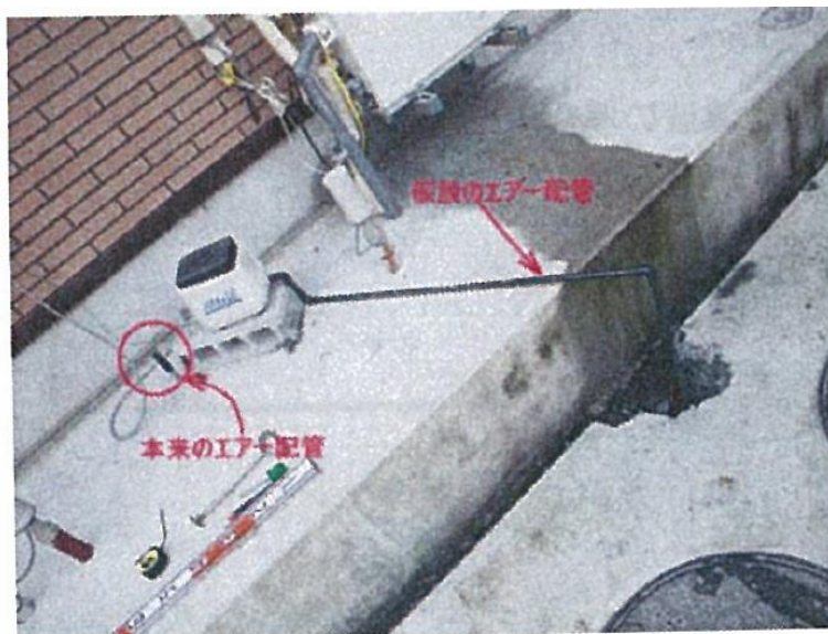
写真8 空気配管の応急修理
