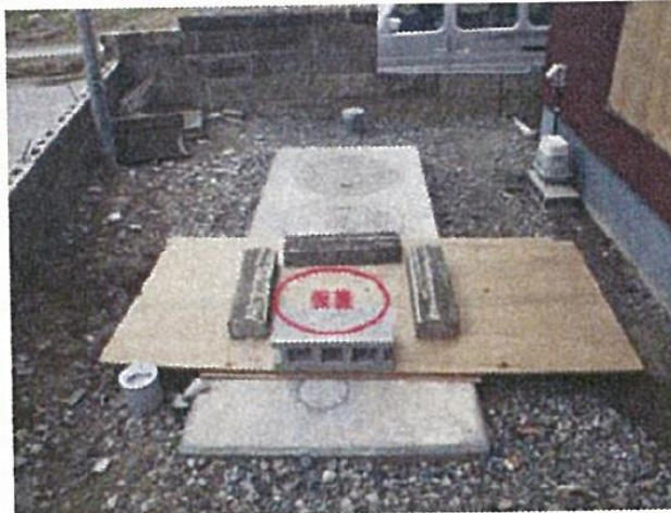
仮蓋を設置した例
