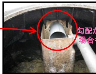
配管の応急修理
