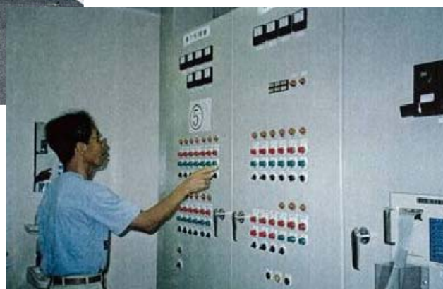
制御盤のメーター異常や警報ランプ点灯異常の点検
