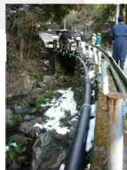
クイック配管(露出配管)(檜原村)
