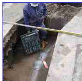
道路線形に合わせた施工(岡崎市)
