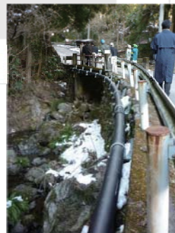
クイック配管(露出配管)(檜原村)
