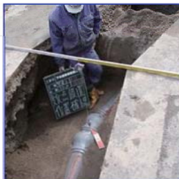
道路線形に合わせた施工(岡崎市)
