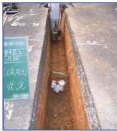
発生土の管きよ基礎への利用(半田市)
