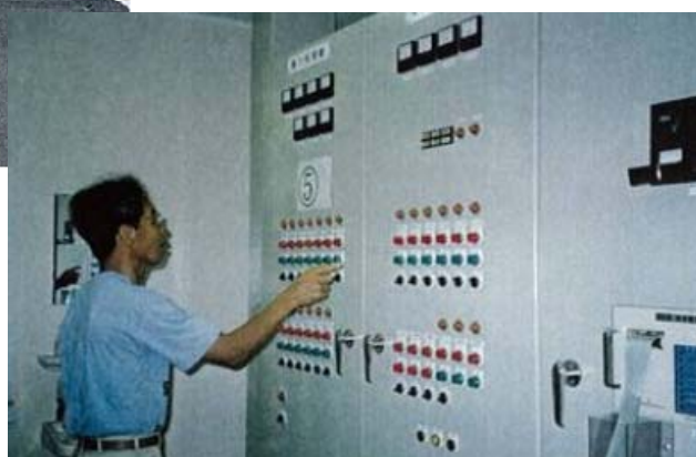
制御盤のメーター異常や警報ランプ点灯異常の点検
