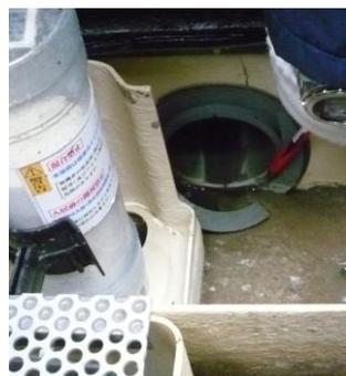
・周辺地盤の陥没により放流管接合部が破損
