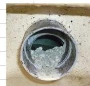
配管破損による土砂の流入
