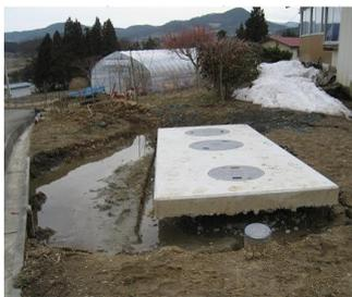
周辺地盤沈下による配管の露出
