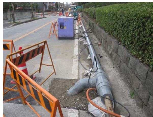
仮設配管 (千葉県 習志野市)
