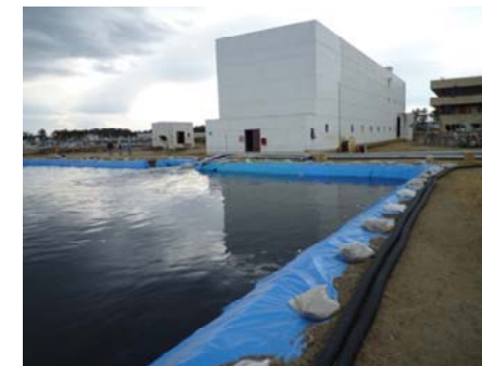
仮設沈殿池 (宮城県 県南浄化センター)
