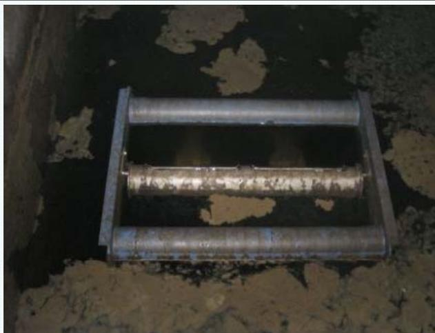
経年劣化により駆動部分が能力低下し、異音・振動が発生
