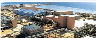
図. 逆浸透法海水淡水化プラント サウジアラビア・メジナ・ヤンブ・フェーズII (8,530m3/日×15基) 出所:三菱重工業株式会社ウェブサイト
