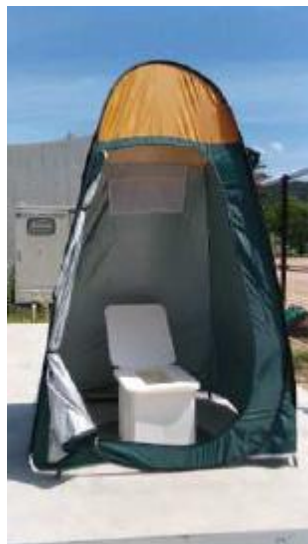
写真2.3 マンホールトイレを設置 した状態
