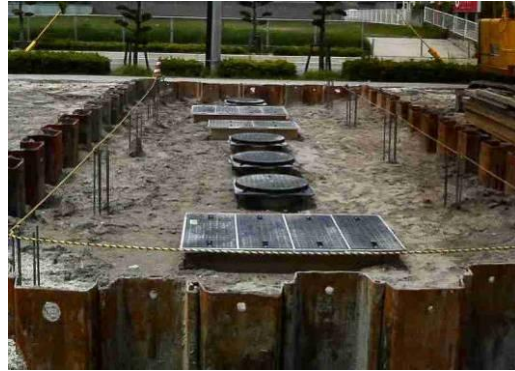
埋め戻し完了
