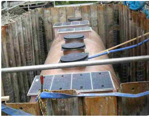
浄化槽据え付け
