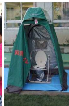
マンホールトイレ設置の様子
