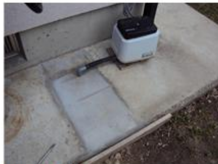
槽外空気配管を修繕 (完全に修理されていた例:高圧な工事と迅速に行われている事例があった)
