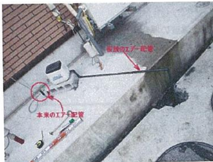
写真 8 空気配管の応急修理
