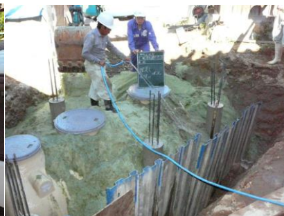
埋戻し・水締め状況
