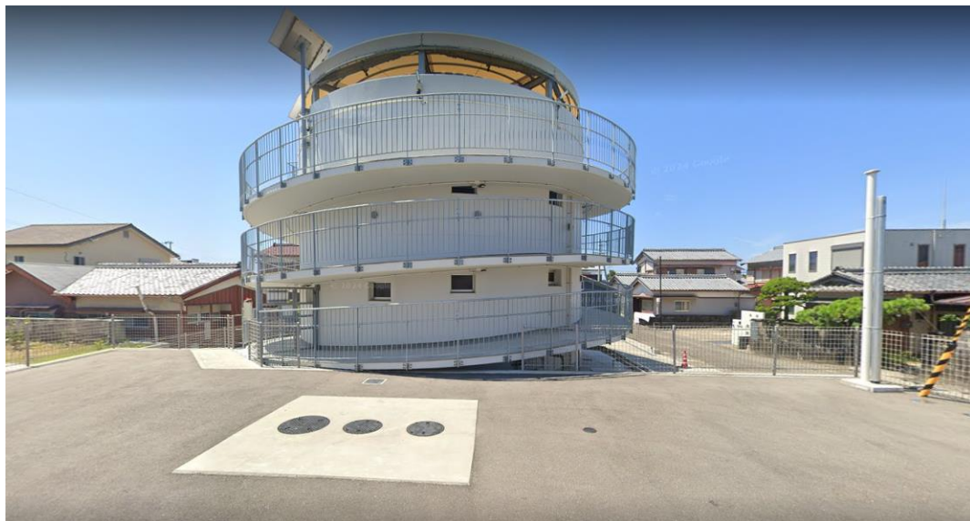
施設全景（手前が設置された FRP 製浄化槽）
