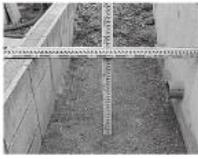
芯出しを行ってますの設置位置を決めます。掘削幅は100mm主管の場合は400mm程度が標準です。砂基礎を50mm築造し、底面は十分に突き固めます。軟弱地盤の場合は砕石または、栗石を敷いてください。
