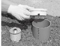
蓋上面とGL面が同じ高さになるように、立上り管を切断して、高さ調整します。蓋と立上り管に接着剤を塗布して接合します。蓋を接合したら、蓋面まで埋め戻します。蓋の保護用ビニルカバーは、工事が完了するまで、取り外さないでください。
