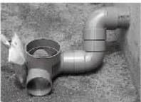
スコップ等を使って、排水枝管をマス受口部のストッパーまで挿入します。この時叩き込みはしないでください。抜け戻りを防止するため、挿入後10～30秒間保持してください。
