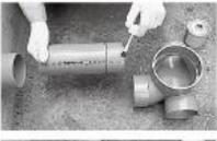
接着剤を排水管外面と、マス受口の内面の両方に塗布し、素早く接合します。
