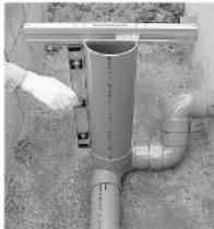
立上り管は、GLまでの長さよりも少し長めに切断し、水平器を使って垂直に接合します。立上り管の余長は埋め戻し後に調整します。
