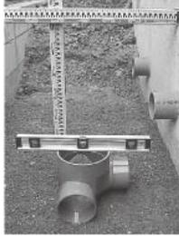
90度合流マス内に勾配が付いているので、本体上部を水平に設置すれば、適切な排水勾配が確保できます。ただし左右兼用マスは勾配が付いていないので、必ず適正勾配を設けてください。
