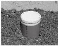
良質土を用いた埋め戻し前に、排水試験を行い、流れの確認を行います。その後、マス内部に土が侵入することを防止するため、蓋を仮設置し、よく突き固めながら埋め戻します。
