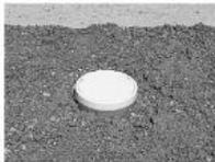
マス内部に土砂が落ちていないことを確認します。スケールなどで管底寸法を測定し、適切な勾配が確保されているか確認します。
