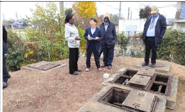
中型浄化槽の視察風景（２）
