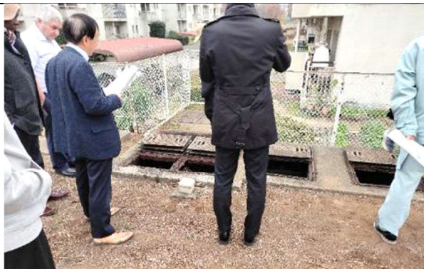
中型浄化槽の視察風景（１）
