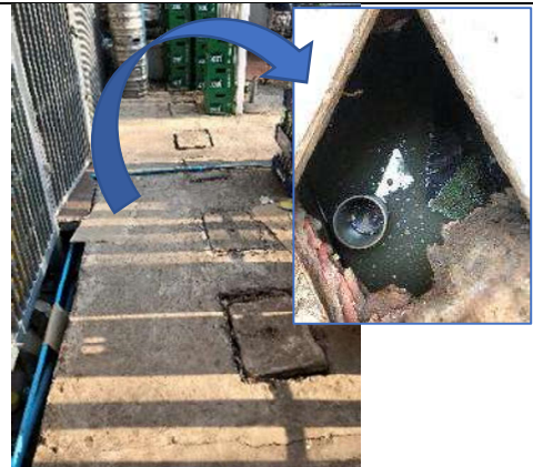
公衆トイレの排水を処理する DEWATS 施設
