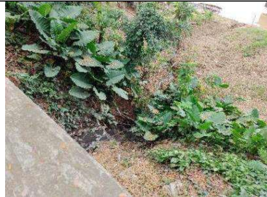
道路反対側にある排水溝
