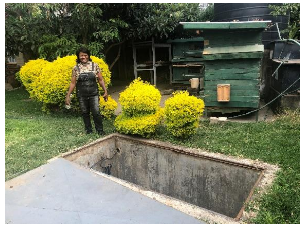
浄化槽の設置状況 (A 宅)
