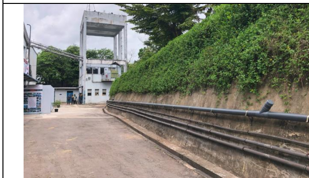
建物から浄化槽までの排水管
