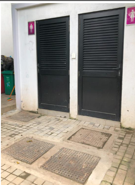
原水ポンプ槽
