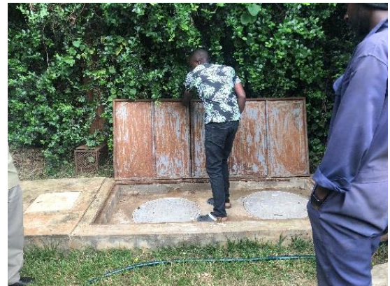
浄化槽の設置状況 (B 宅)
