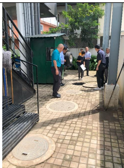
浄化槽の設置状況
