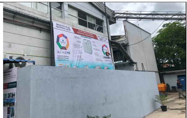
浄化槽の設置状況（地上設置）
