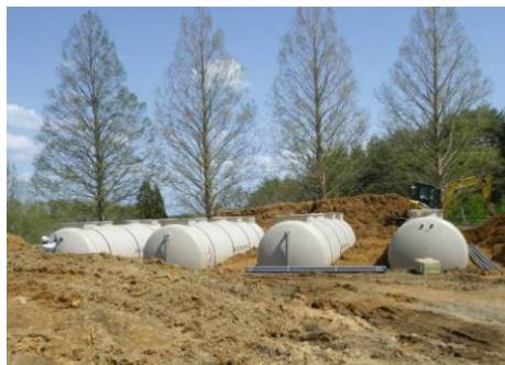
浄化槽据え付け・半地下埋設
