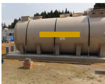
浄化槽据え付け・転倒防止措置
