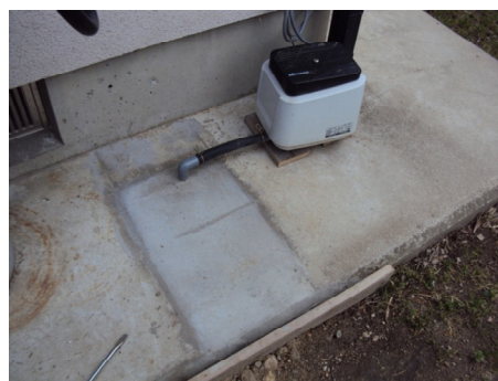
槽外空気配管を修補 (完全に修理されていた例: 簡便な工事は迅速に行われている事例があった)
