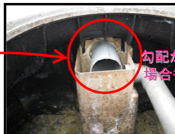
配管の応急修理
