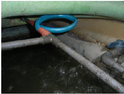
内部空気配管の切断→ホースによる接合を行った例
