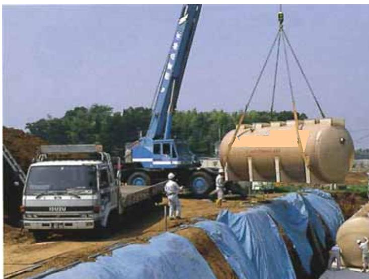
図 3-6 規模の大きな浄化槽の例 (設置工事中)
