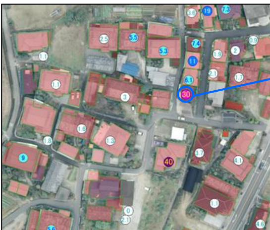
放流水質の状況：写真の○の中の数値が各浄化槽の放流 BOD を表している。
