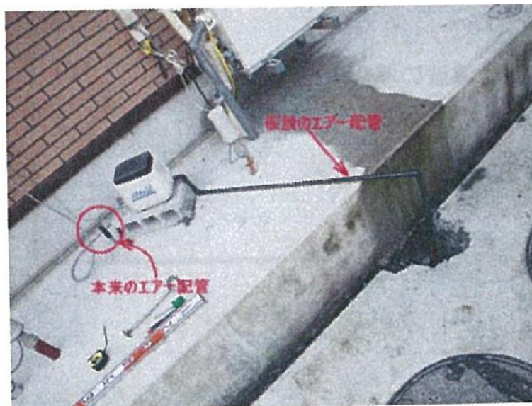
写真 8 空気配管の応急修理
