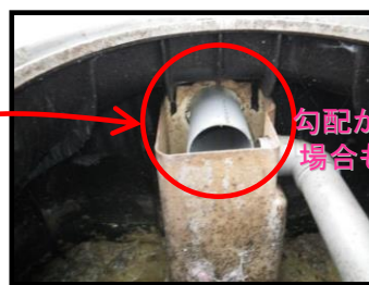
配管の応急修理
