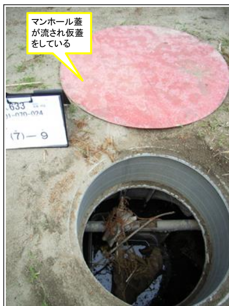
仮蓋を設置した例
