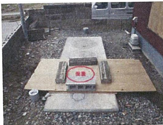
仮蓋を設置した例
