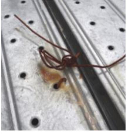
×足場板を番線により固定
