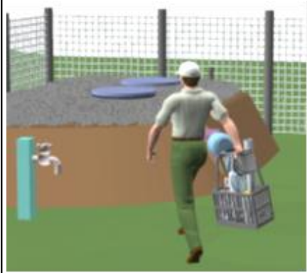
○盛土の上面を砂利で被覆
