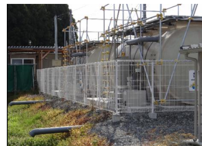
槽周辺のフェンス
