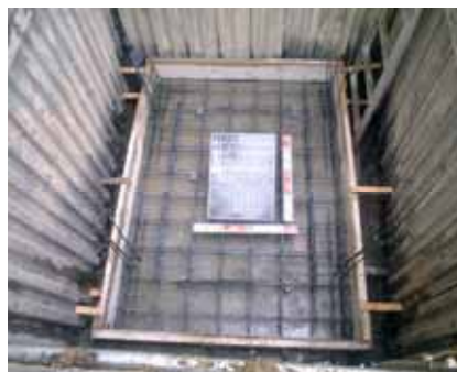
鉄筋コンクリート打ちの例
