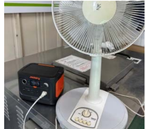
空調補助（換気）
