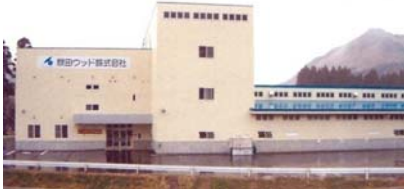
廃プラスチック利用新建材製造事業
