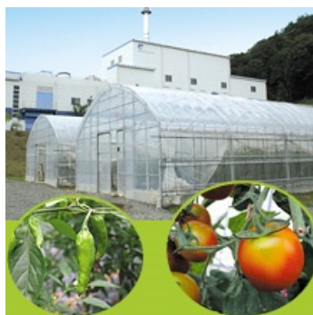
図 1-17 CRP の温室栽培施設
