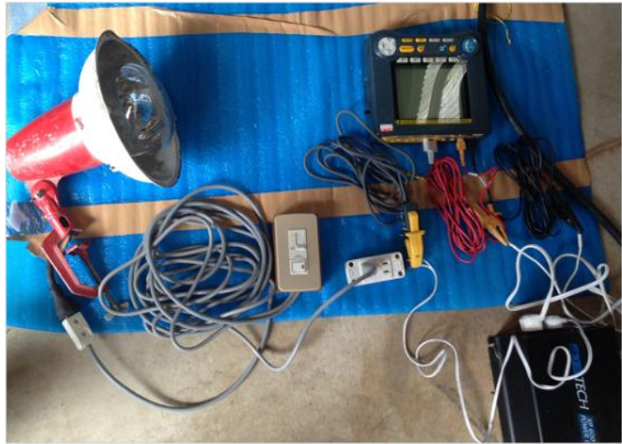
接続（燃料電池インバータ）
