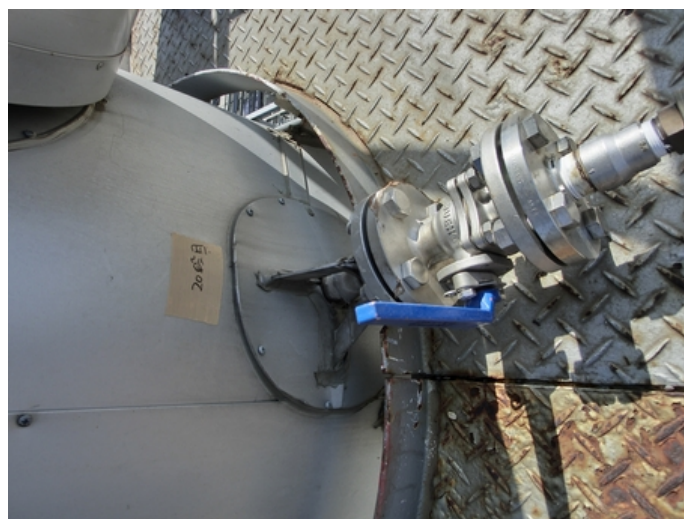
図 3-10 30%濃度バイオエタノール抽出用の抜出点（蒸留塔の 20 段目）
