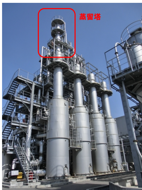
図 3-9 バイオエタノール精製設備（最も高いのが蒸留塔）
