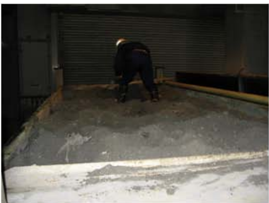
⑦焼却灰整地作業
