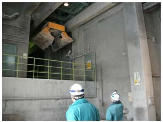
⑥天井クレーン
