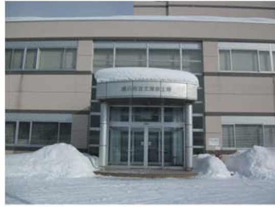
②旭川市近文清掃工場正面玄関
