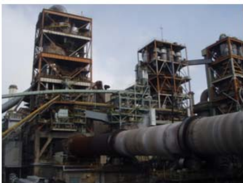
㊪ キルン(8号)とサイクロンプレヒーター。
