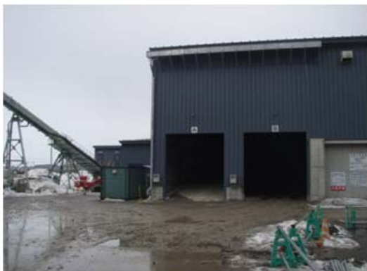
㊦ 窯灰投入設備建屋入口。屋内に、焼却灰を投入するホッパー、ベルトコンベアーが設置されている。
