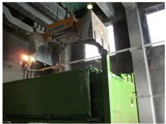
④焼却灰積込状況1
