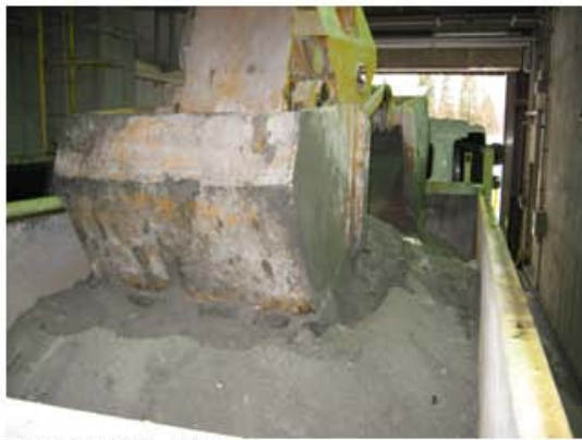
⑤焼却灰積込状況
