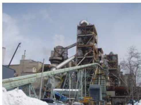
㊩ キルンへと延びる窯灰投入設備。焼却灰は内部のコンベアーにて送られる。
