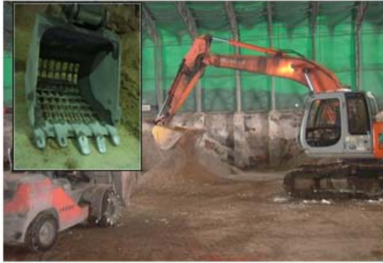
㊸スケルトンバケット(左)と同バケットを装着したユンボによる異物の除去。
