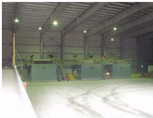
㊧ 窯灰投入設備建屋内の廃棄物投入用ホッパー。
