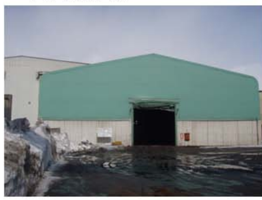
④焼却灰を荷卸・保管したリサイクルヤード。
