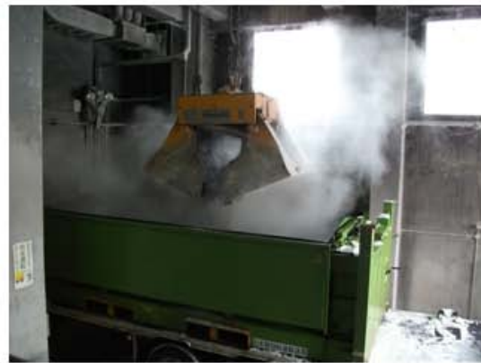
⑤焼却灰積込状況2
