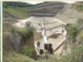
采用准好氧填埋构造的在建中的处理场
