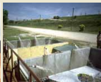
渗滤液处理设施
