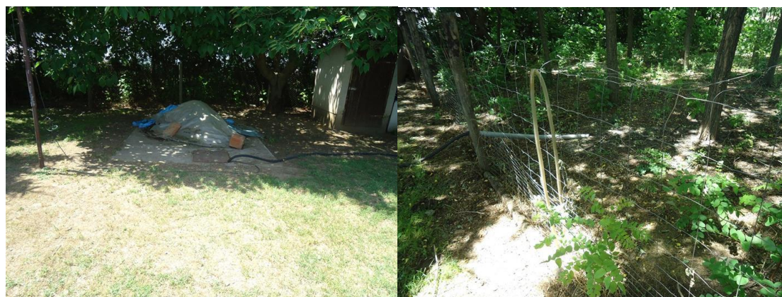
写真 3.1-2 未処理排水の森林への放流（コンクリートタンクから森林へ圧送）
