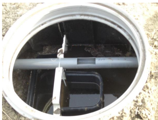
写真 5.1-1 嫌気ろ床槽の状況
