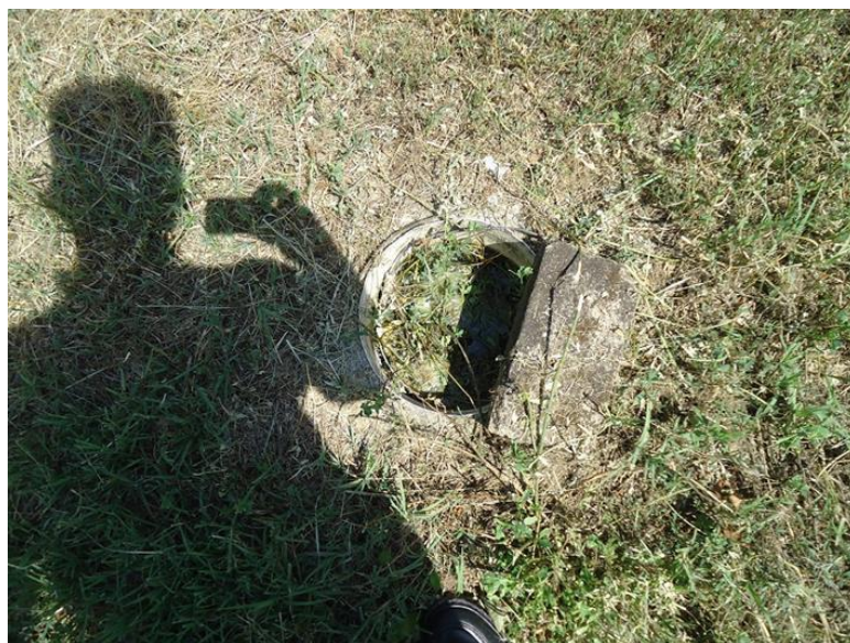
写真 3.1-1 地下浸透(未処理排水)
