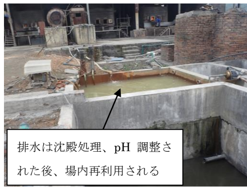
処分場予定地内の状況 (排水処理状況)
