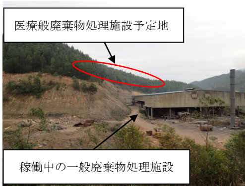
処分場予定地の状況
