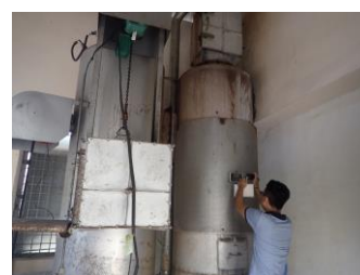
導入した焼却装置
