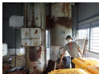
焼却装置外観
