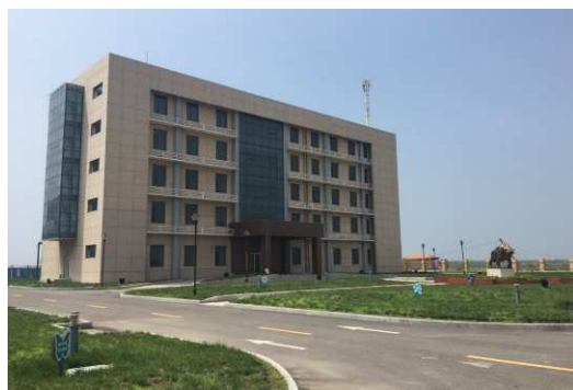
図 2. 2 5 工場敷地内の様子その 1
