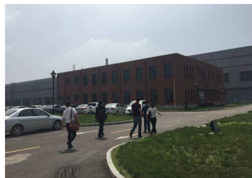
図 2. 2 6 工場敷地内の様子その 2
